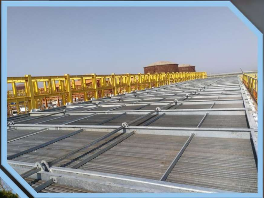
ساخت و نصب Air Cooled Heat Exchanger پروژه بید بلند خلیج فارس پکیج B
